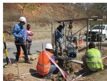
水道工事を指導する千葉県企業局職員 (千葉県企業局提供)
