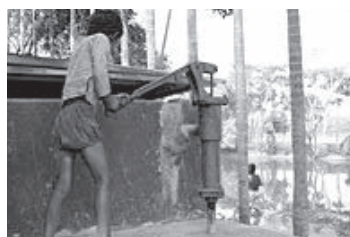
© UNICEF Bangladesh/2009/Sharmin 水源がヒ素で汚染されているため、手押しポンプでくみ上げた水をサンドフィルターに通してきれいになっている。(バングラデシュ)
